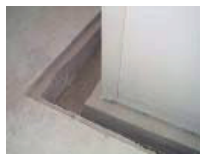
Dettaglio Scavo Excavation example
